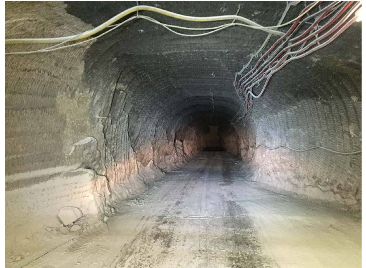
Quelle: BGE Asse II – 725-m-Sohle
